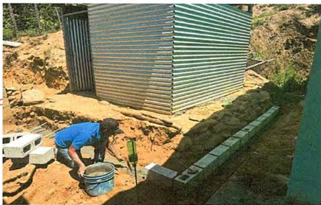
Foto 1: Reparación y sustitución de Área de cocina.
