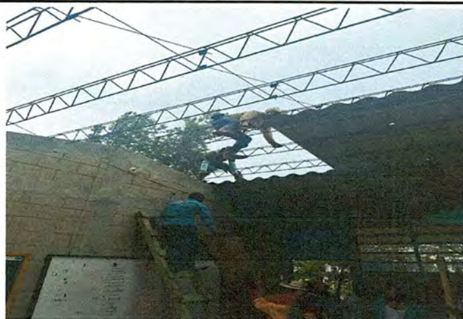
Foto 4: Cubierta de lamina.
